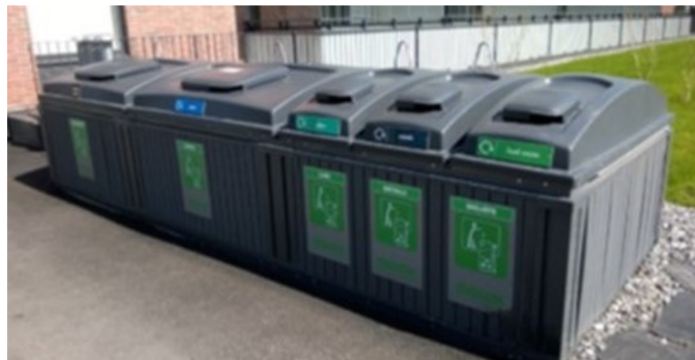
Syväkeräyssäiliöiden avulla voidaan minimoida jätehuollon tilantarve. Eri toimintoja voidaan rajata esim. pensaiden avulla visuaalisesti toisistaan. Kuva Tampereen kaupunki 2020.
